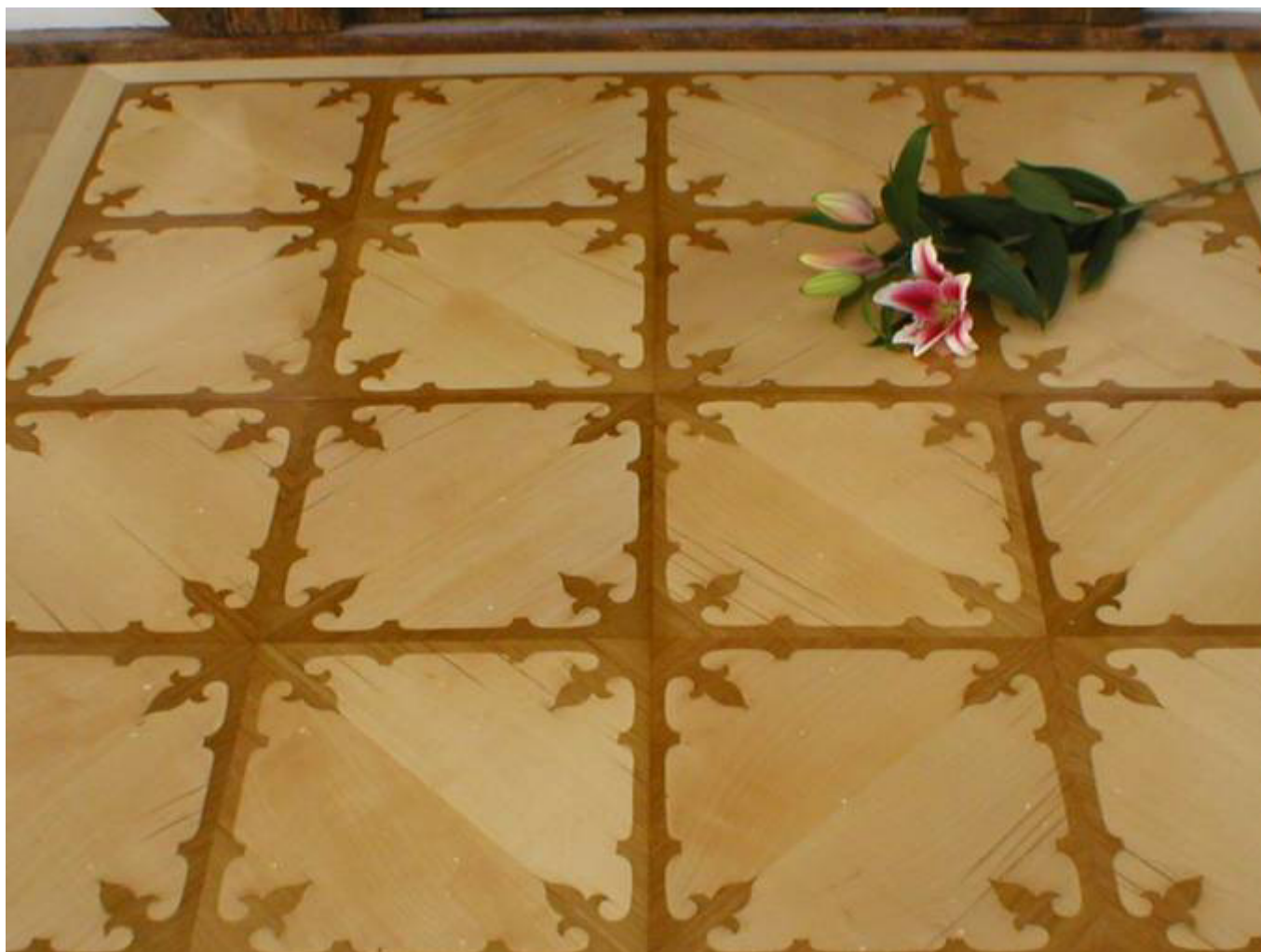
Musterfläche aus sanierten Tafeln
